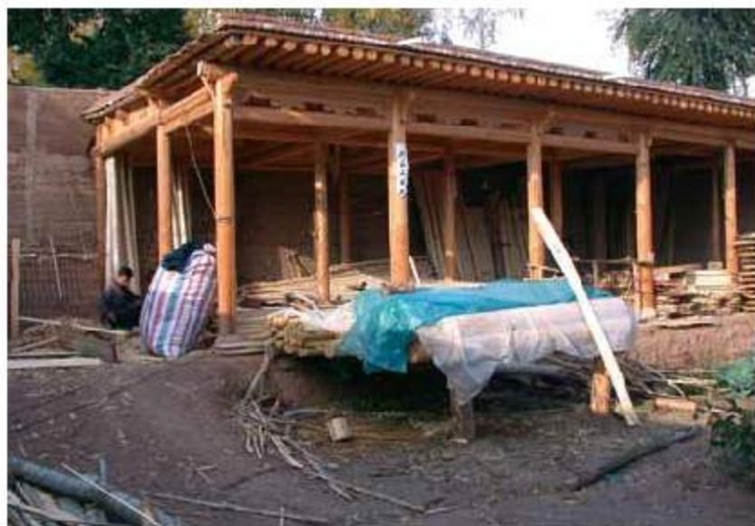
Abb. 2: Die Holzkonstruktion des Wohnhauses wird gebaut. Das Haus hat ein Pultdach in Westchina.
