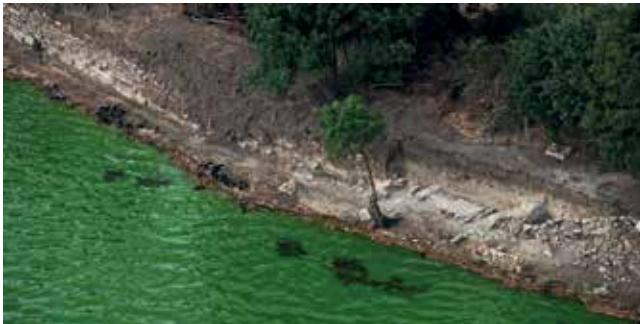
Terrassenmauern (Ş. Aydıngün) / Teras duvarları (Ş. Aydıngün)
