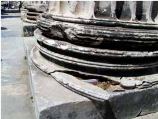
Säule A2 des Apollon Tempels. Abgeplatzt Fragment der Basis (D. Mauermann) / Apollon Tapınağı'nın A2 sütunu. Kaidenin yerinden oynanmış parçası (D. Mauermann)
