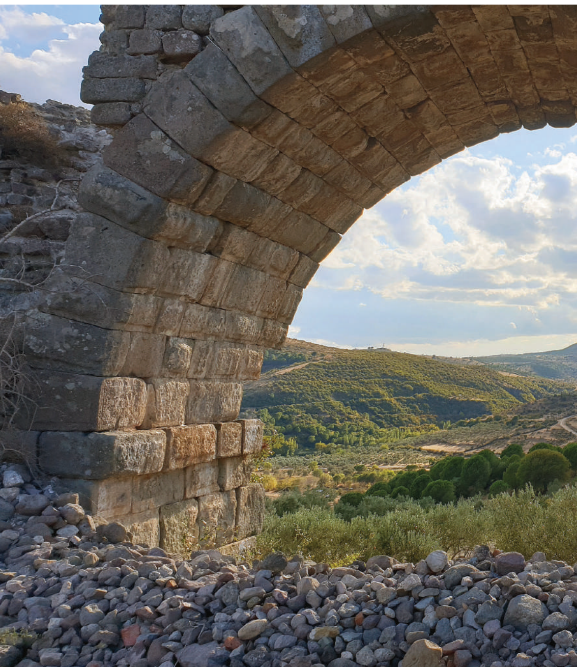
Abb. 14. Ein Blick durch das Aquädukt von Pergamon in die Kozak-Ebene / Res. 14. Pergamon Su Kemerî'nden Kozak Yaylası'na doğru bakış
