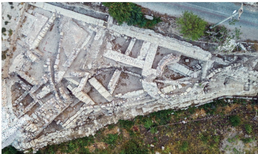
Abb. 2. Ansicht der östlichen Uferbefestigungen des Bergama Çayı (Selinus) / Res. 2. Bergama Çayı'nın (Selinus) doğu kıyısındaki tahkimatın görünümü
