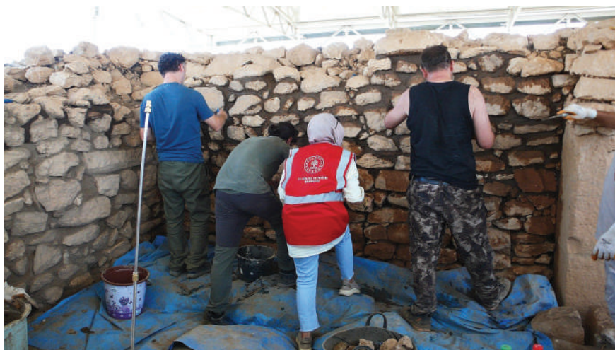
Abb. 18. Neuverfugen mit Erdmörtel – Schulung von Studenten und Museumspersonal / Res. 18. Derzlerin toprak harçla yeniden doldurulması – Öğrencilerin ve müze personelinin eğitimi
